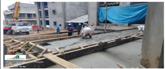
Fig. 2.- Vaciado de concreto premezclado F'c=175 kg/cm 2 de veredas colindantes a la rampa R-11C.
