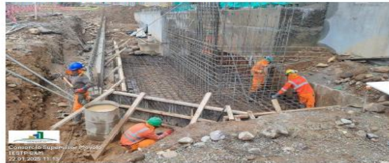
Fig. 3.- Armado (acero y encofrado) de zapatas para el puente peatonal entre el Bloque C y Bloque F.
