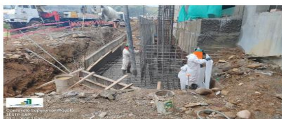
Fig. 5.- Vaciado de concreto premezclado F'c=210 kg/cm 2 de zapatas para el puente peatonal entre el Bloque C y Bloque F.
