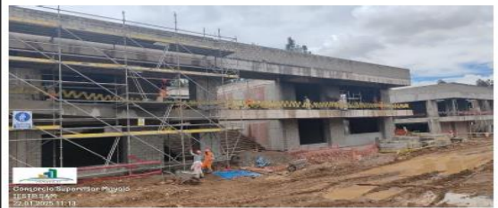
Fig. 4.- Tarrajeo 1:4 de fachada exterior del Sub Bloque F1.
