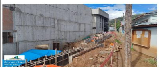
Fig. 6.- Armado (acero y encofrado) para la rampa R-05.
